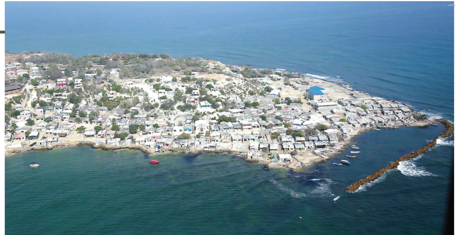
Vista aérea de las obras de protección costera de Tierrabomba.
