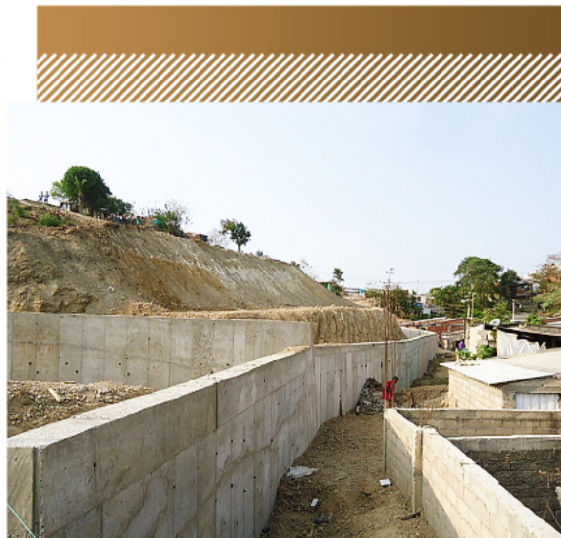
Obra en ejecución, Loma del Marión - Distrito de Cartagena de Indias Archivo Cardique
