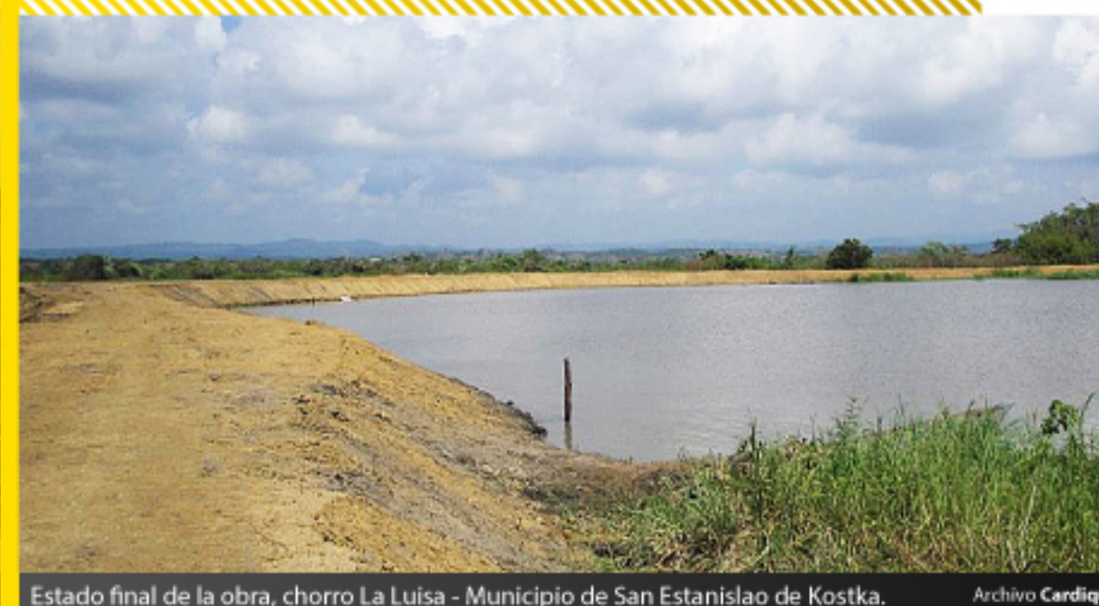
Estado final de la obra, chorro La Luisa - Municipio de San Estanislao de Kostka.
