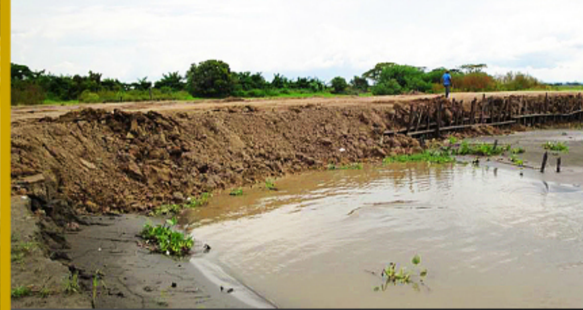
Estado final de la obra, Municipio de San Cristóbal. Archivo Cardique
