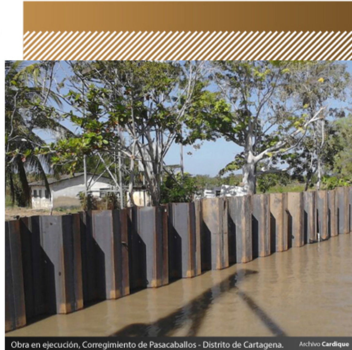
Obra en ejecución, Corregimiento de Pasacaballos - Distrito de Cartagena. Archivo Cardique
