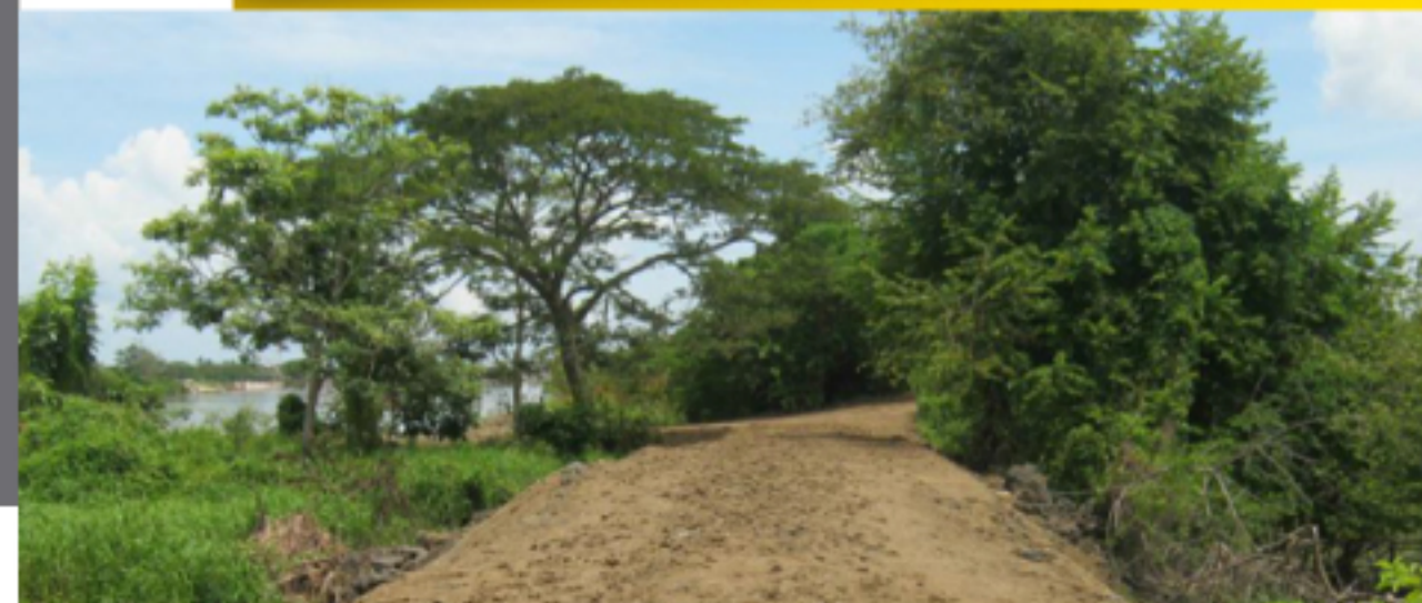
Estado final de la obra, Municipio de Calamar. Archivo Cardique
