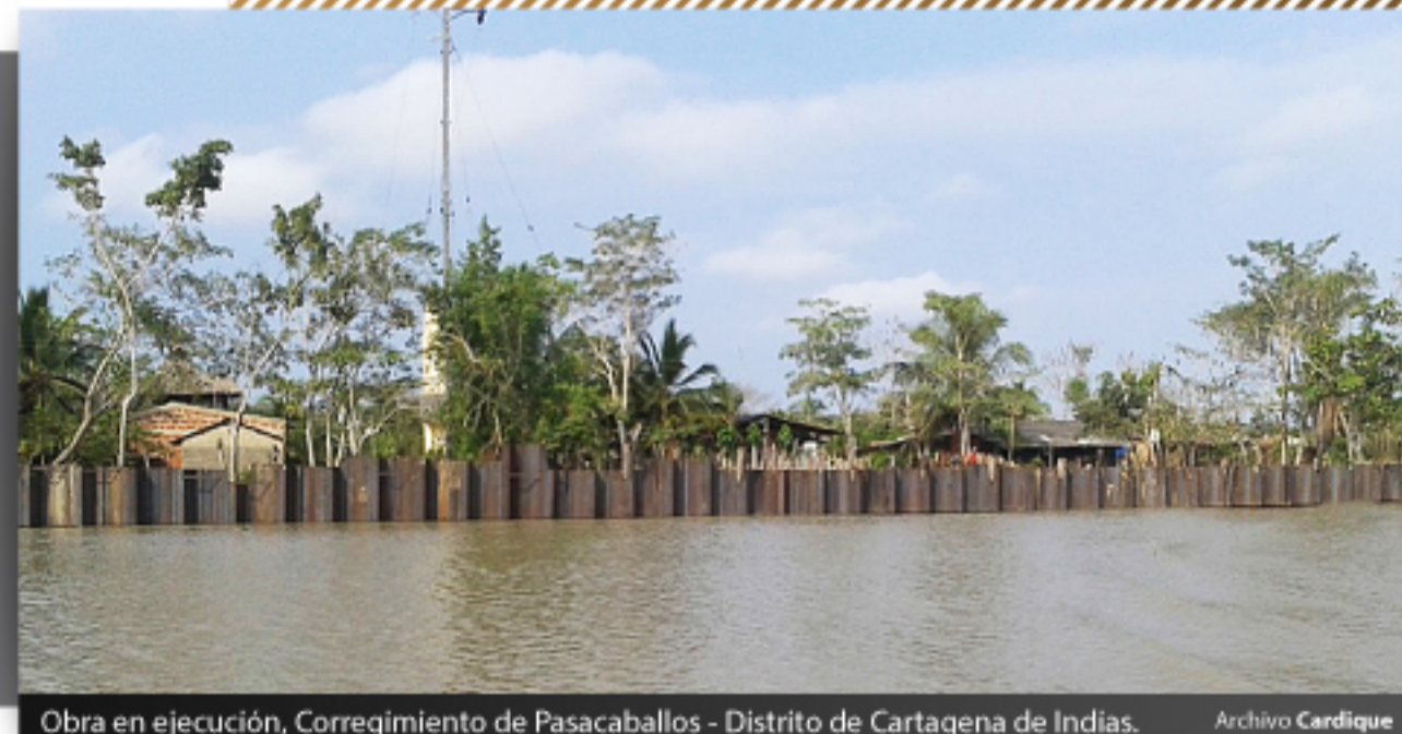
Obra en ejecución, Corregimiento de Pasacaballos - Distrito de Cartagena de Indias. Archivo Cardique
