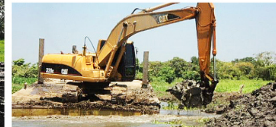
Obra en ejecución, Municipio de Mahates Archivo Cardique
