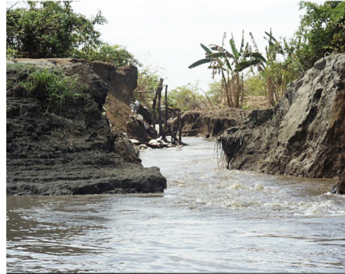
Estado inicial de la obra, Municipio de Calamar. Archivo Cardique
