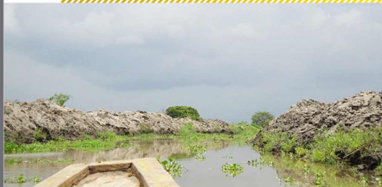
Estado final de la obra, chorro Jobo - Municipio de San Cristóbal. Archivo Cardique
