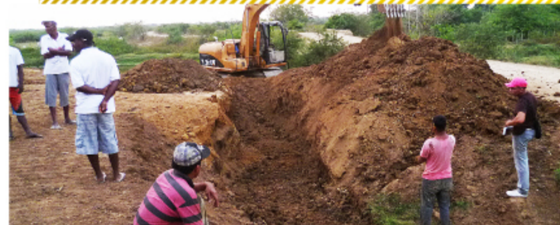
Obra en ejecución, Municipio de Calamar. Archivo Cardique
