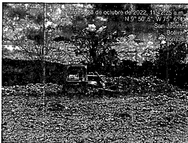
Imagen 6 y 7. Disposición y compactación de residuos fuera de la celda actual.
