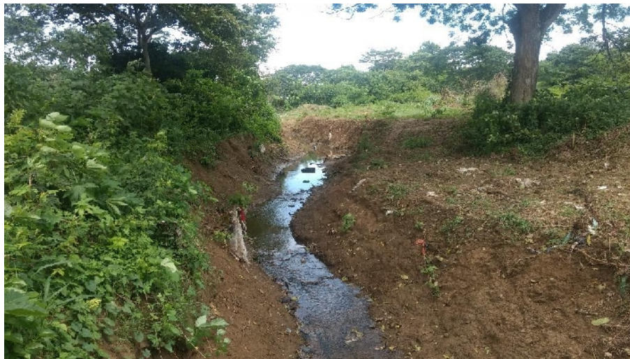
Figura 2.8. Arroyo Capital en el municipio de Arjona. Elaboración propia.
