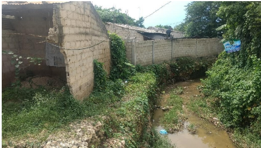
Figura 2.9. Muro en gaviones en el arroyo Arena, del municipio de Arjona. Elaboración propia.
