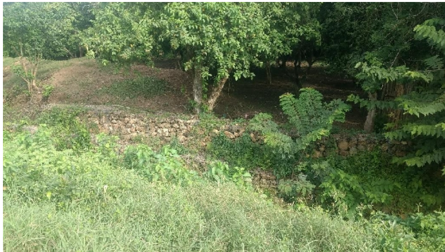
Figura 2.1. Muro en gaviones a la entrada del municipio de Arroyohondo. Elaboración propia.
