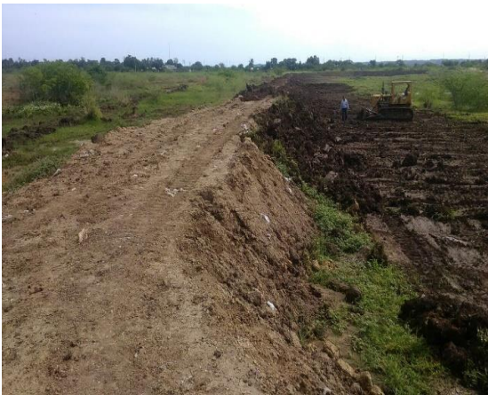
Reforzamiento Jarillón Z. Occidental Municipio de Canoa Zambrano
