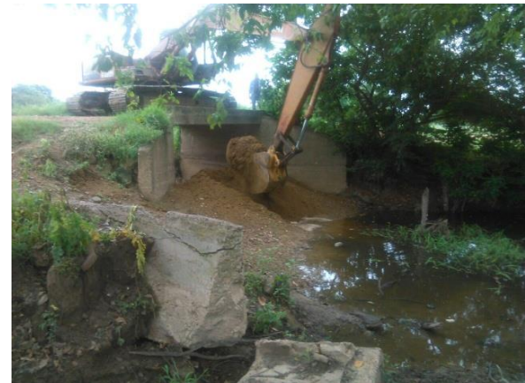
Mtto. Puente Caracolí, El Roble Municipio de El Guamo
