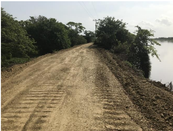
Reforzamiento Jarillon paralelo Canal del Dique Municipio San Estanislao de Kostka
