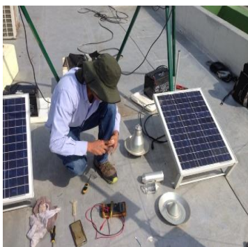
Mantenimiento Paneles Solares
