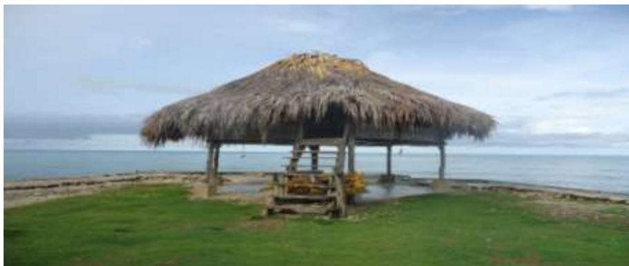
**Foto: kiosco construido en madera, piso en cemento pulido y techo de palma**
