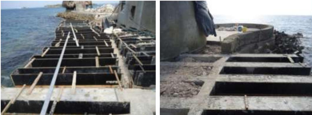
Vigas en concreto sobre el muro de protección costera.
