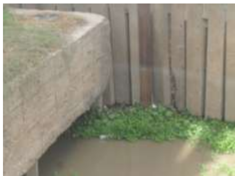
Foto No. 1. Detalle socavación Pila
