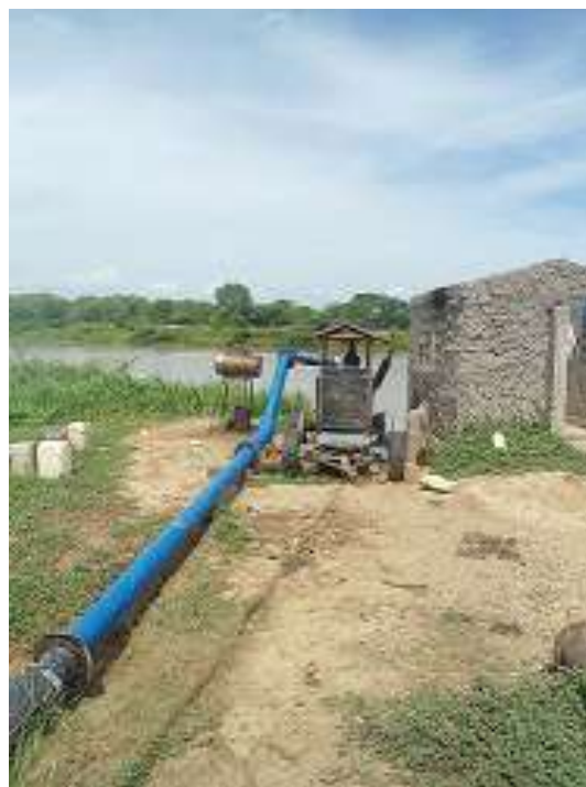
Fotografía No. 2 Captación desde el Canal del Dique Como se observa en la fotografía No. 1 el canal que viene de la Ciénaga se encontraba seco, por lo que la captación se realizaba desde el canal
