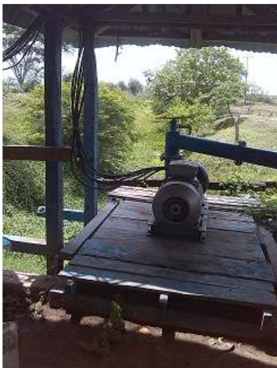
Fotografía No. 1. Captación Sobre el canal
