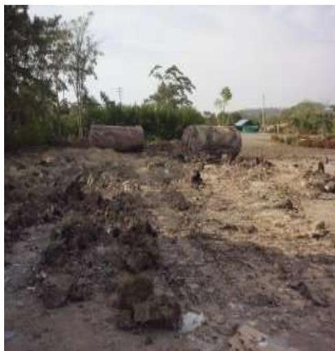
Foto No 2. Remoción de suelos contaminados con hidrocarburos y desenterrado de tanques de almacenamiento de combustibles.
