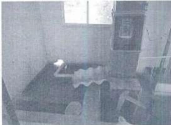
Fotografía 2. Pozo de aguas crudas (pozo sucio) y el Dosificador de Sulfato de Aluminio
