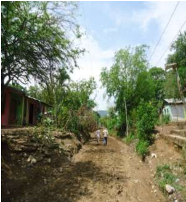
Fotos: 2, Aspecto de las viviendas ubicadas en el sector el Campito, donde se desarrollara el proyecto de electrificación
