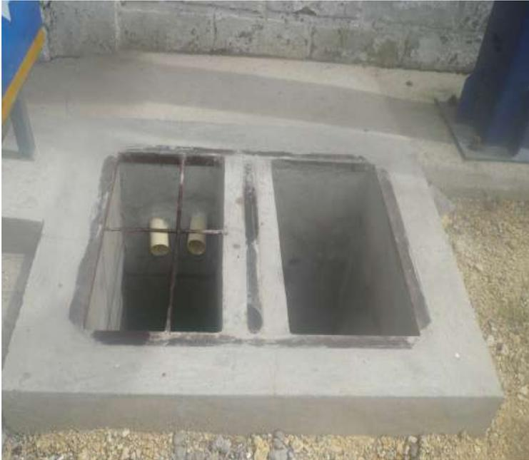
**Foto No 3. Trampas de grasas para manejo de aguas lluvias.**
