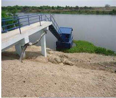
Foto 1. Sitio de captación y barcaza flotante
