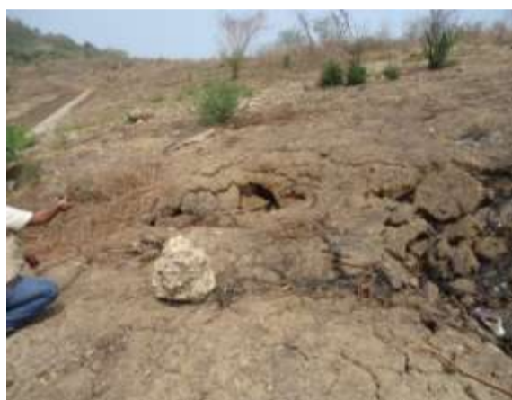
Foto 13. Agrietamiento suelo del relleno por quema de residuos sólidos dispuestos en el relleno Foto 14. Quema de vegetación en el relleno sanitario.
