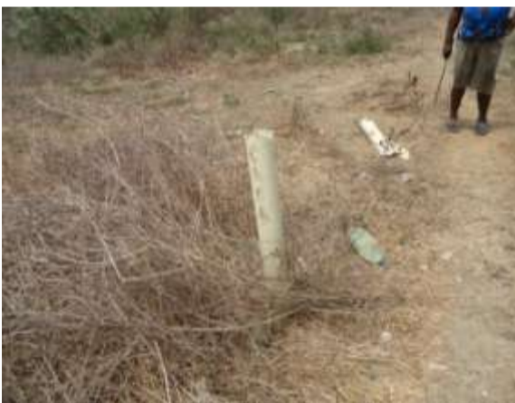
Foto 9. Chimenea de evacuación de gases deteriorada.
