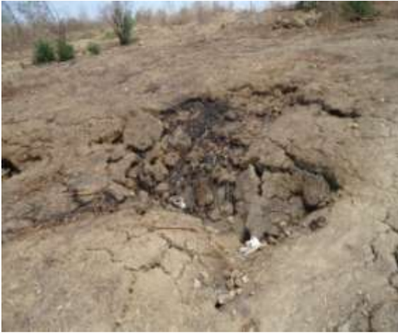
Foto 5. Agrietamiento suelo del relleno por quema de residuos sólidos dispuestos en el relleno.
