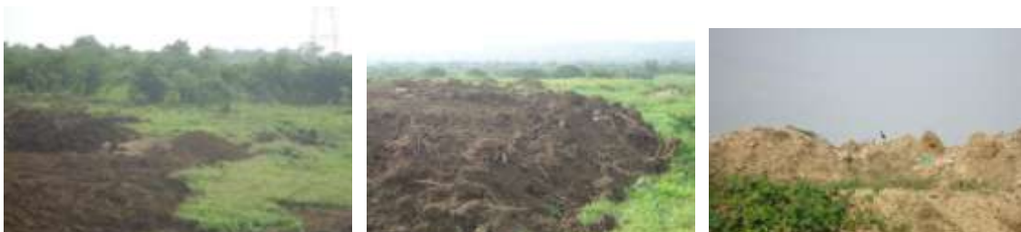
Imagen #3: Disposición inadecuada de material de relleno, sobre capa vegetal
