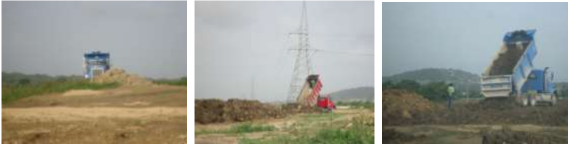
Imagen#2: Disposición de escombros en el lote
