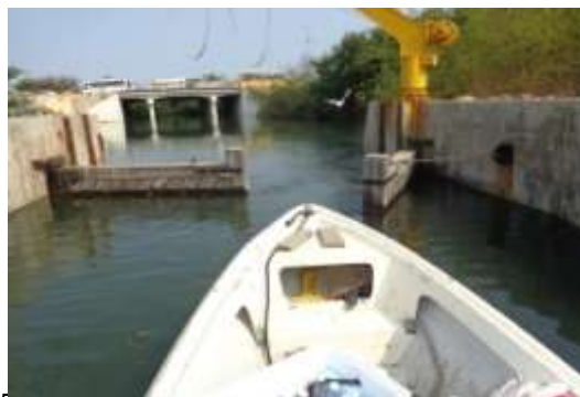
Foto No 1. Pescante y compuertas en el puente de chambacú.
