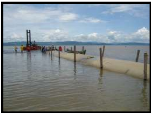
GEOTUBO FORTEX® lleno Llenado de GEOTUBOS FORTEX®
