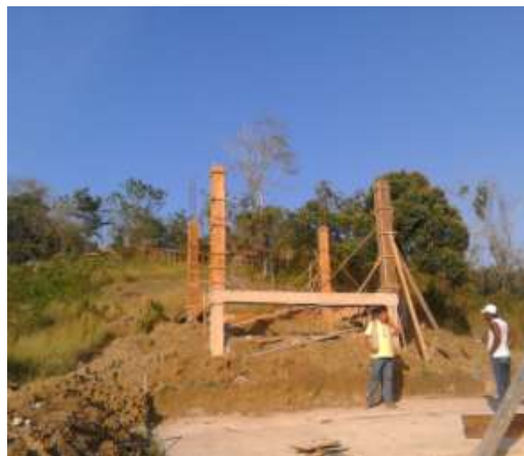
Base para tanque elevado.
