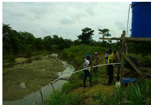
Fotografía 2. Arroyo Toro, diques y estado actual
