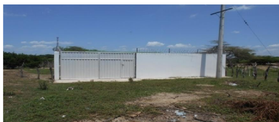
Foto 1. Puesto de bomba.
