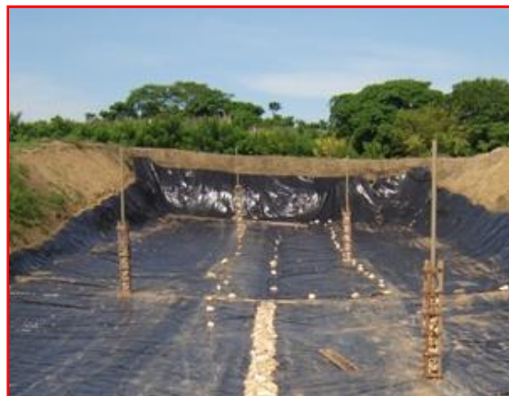
Fotografía 3. Chimeneas de gases proyectadas
