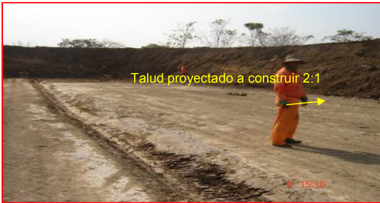
Fotografía 2. Construcción de talud en la conformación del vaso de vertimiento o trinchera
