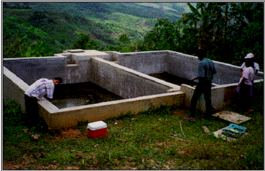
Ilustración 2-7.Piscinas de sedimentación
