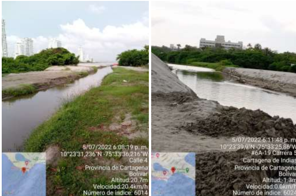
Ilustración 15. Evidencia fotográfica de los canales El laguito en visita calibración.
