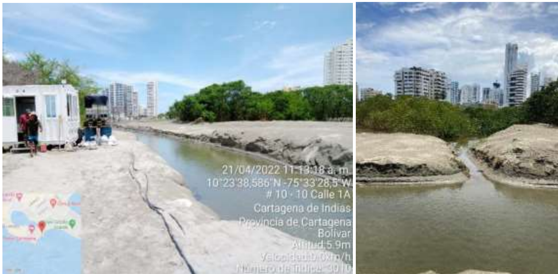
Ilustración 11. Evidencia fotográfica de la buena condición del canal de comunicación Mar-Laguito.
