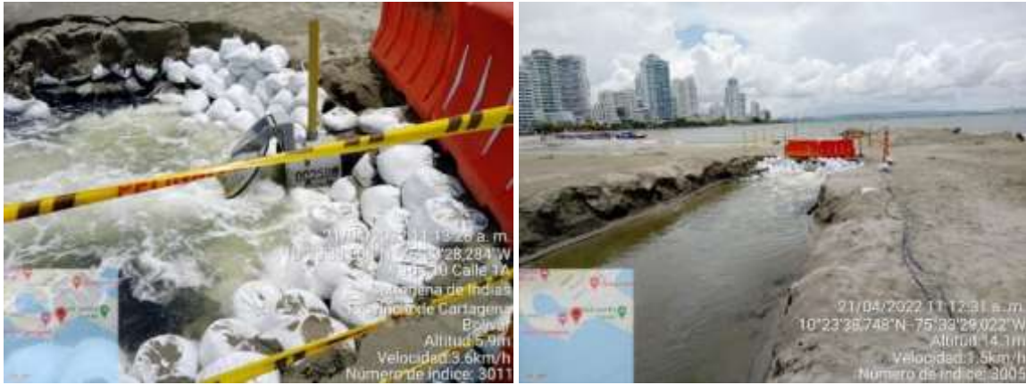
Ilustración 10. Evidencia fotográfica de la operación de la bomba de intercambio en el cuerpo de agua El laguito.
